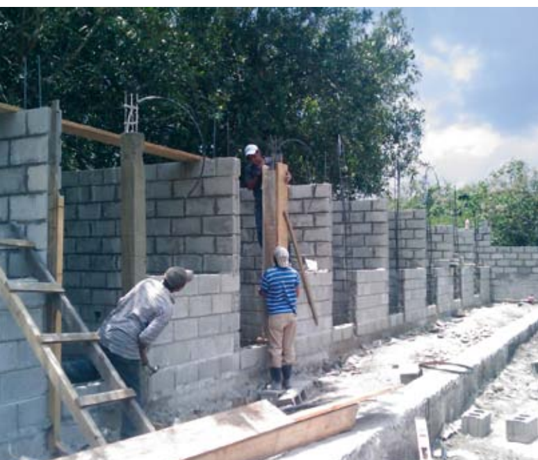
Construcción del complejo comercial de artesanías
