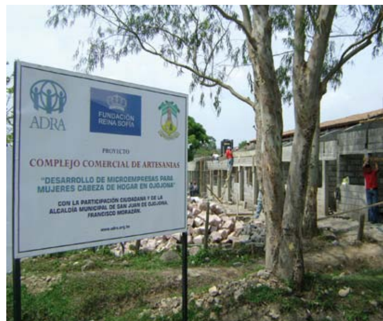
Cartel anunciador de las construcciones
